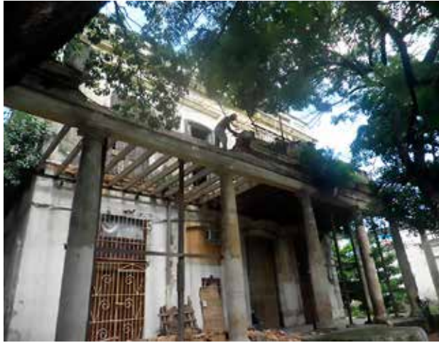
Antigua residencia de Línea y B, Vedado.
