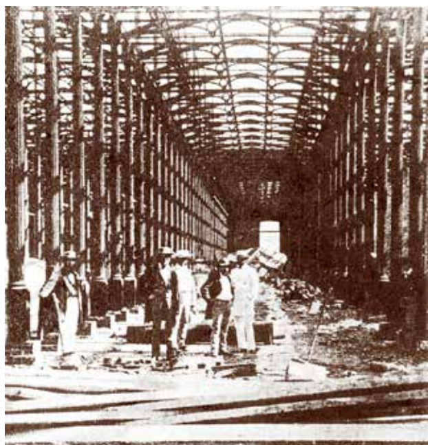
Almacenes de Santa Catalina en construcción, 1860. (Foto de George Barnard).
